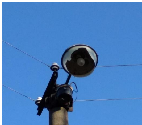
Obr. 13: Rozbitý kryt
