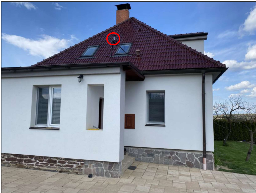
Měřicí bod D1 - 2 m před oknem obytné místnosti v 2.NP RD Hulice čp. 10
