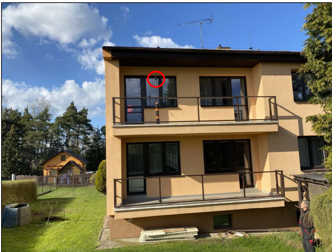
Měřicí bod D2 - 2 m před oknem obytné místnosti v 2.NP RD Hulice čp. 16
